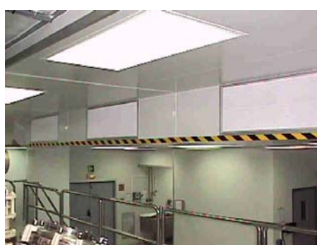
Detalle filtros terminales
